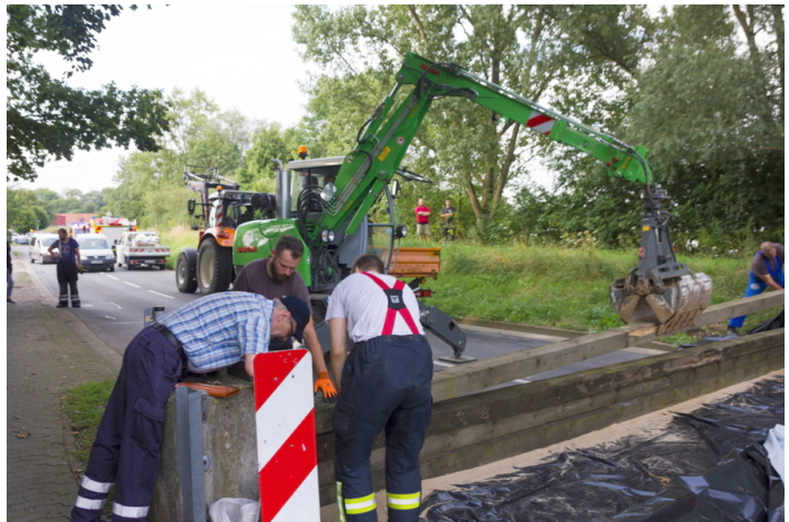
Die ehrenamtlichen Helfer sichern den Ortseingang in Wilkenburg mit Sandsäcken, Plane und Holzbalken.
