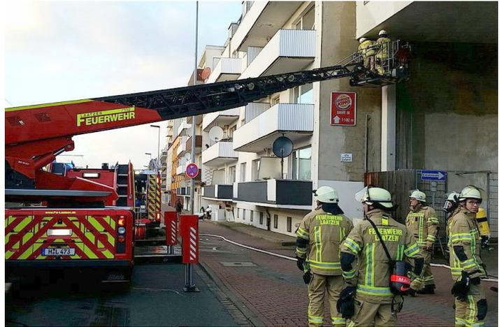
**Von der Drehleiter aus wird die Verkleidung der Decke (Wärmeverbundsystem) mit einer Wärmebildkamera kontrolliert.**
