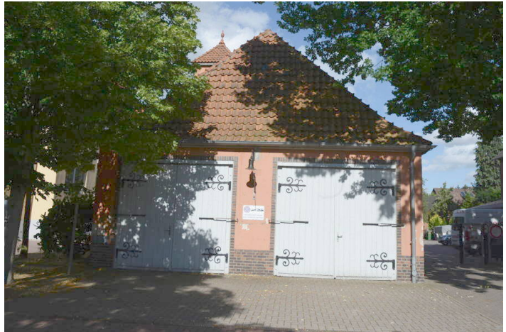
Das ehemalige Spritzenhaus an der Marienstraße wird verkauft. Das entschied der Rat gestern.
