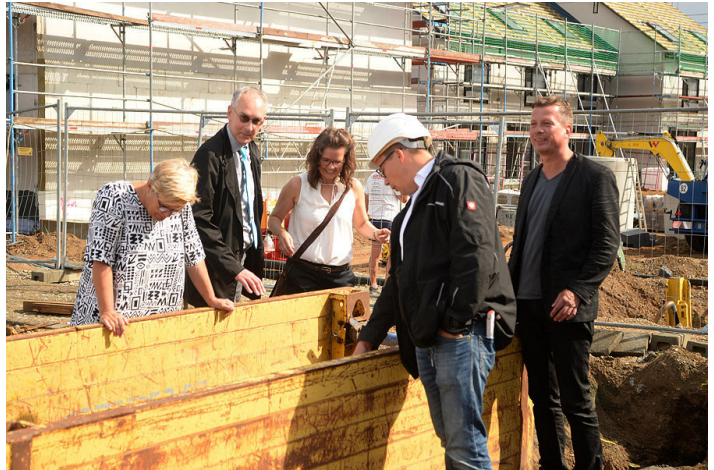
Bauleiter Daniel Henke (mit Helm) von der Deutschen Reihenhäuser AG erläutert Bürgermeisterin Heike Brennecke, Bauamtsleiter Rembert Andermann und Stadtmanagerin Andrea Satli den Vorgang der öffentlichen Anschlüsse für den neuen Wohnpark in der Glückauf-Straße. Rechts im Bild: Achim Behn, Leiter der Presse- und Öffentlichkeitsarbeit der Deutschen Reihenhäuser.
