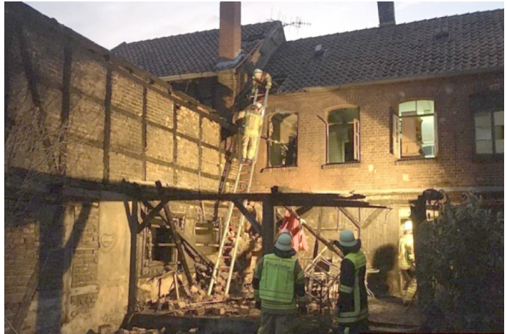
Die Feuerwehr Sarstedt löscht in der Holztorstraße das ausgebrochene Feuer.
