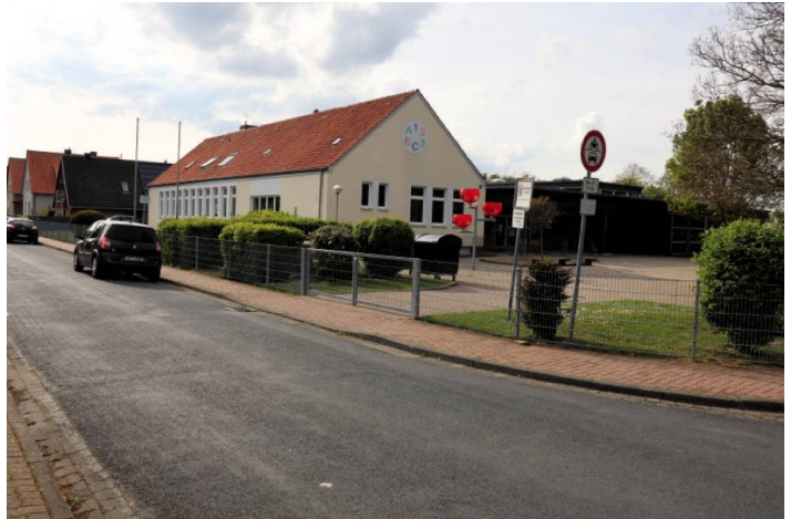
Der Grundschulstandort an der Teichstraße wird in absehbarer Zeit aufgegeben.
