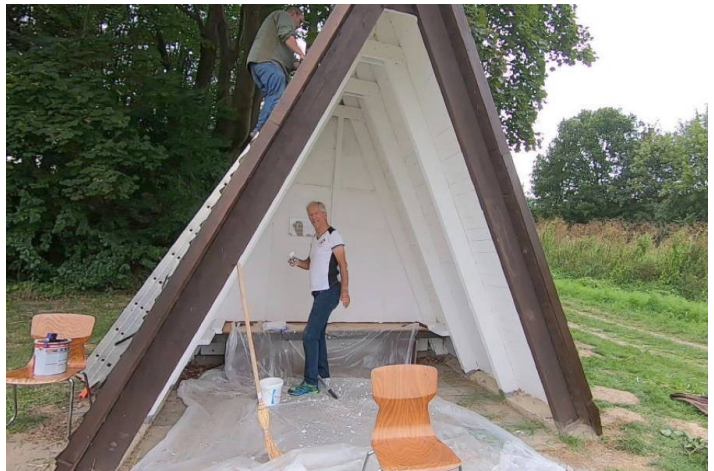
Klaus Iffland streicht die Wände weiß, während Arndt Brinkmann (links) in luftiger Höhe Schutzlack aufbringt.
