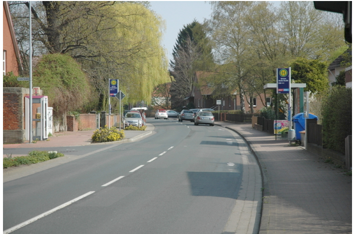
Die Ortsdurchfahrt Devese wird demnächst saniert.
