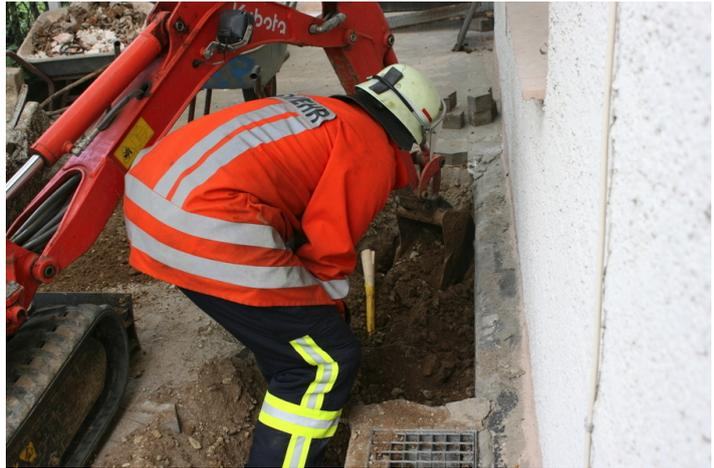
**Mit einem Holzkegel haben die Feuerwehrkameraden die Gasleitung provisorisch abgedichtet.**
