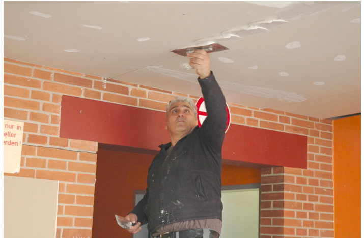
Georgios Dermitzakis verputzt die neue Gipskartondecke im Vorraum zur Turnhalle.
