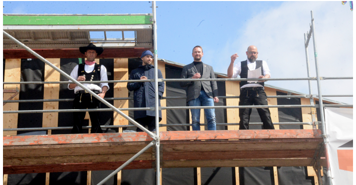
Christian Levers (rechts) von der Baufirma Thiemt GmbH spricht im Beisein seines Kollegen Maik Rolwers, Phillip Sander vom Architektenbüro CKRS und Christoph Neuber (Stadtverwaltung Sarstedt) den Richtspruch. © Reinhard Kroll
