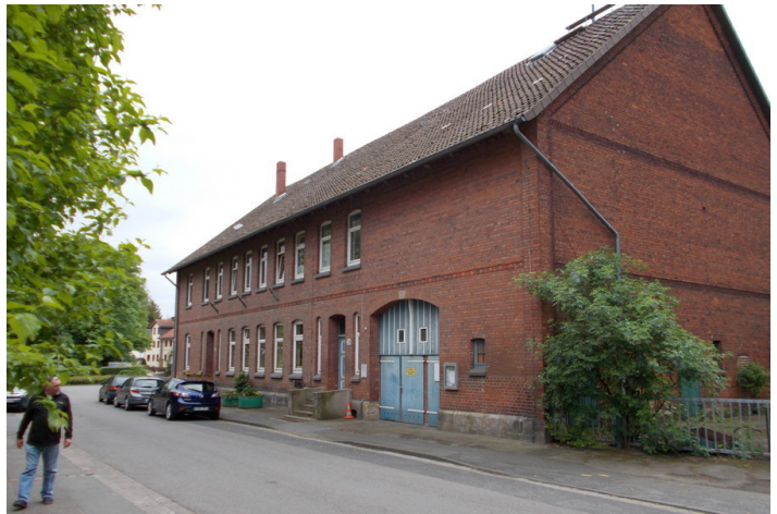
Die Alte Schule an der Rethener Thiestraße wird das neue Domizil des Jugendzentrums Buchte. / Foto: R. Kroll
