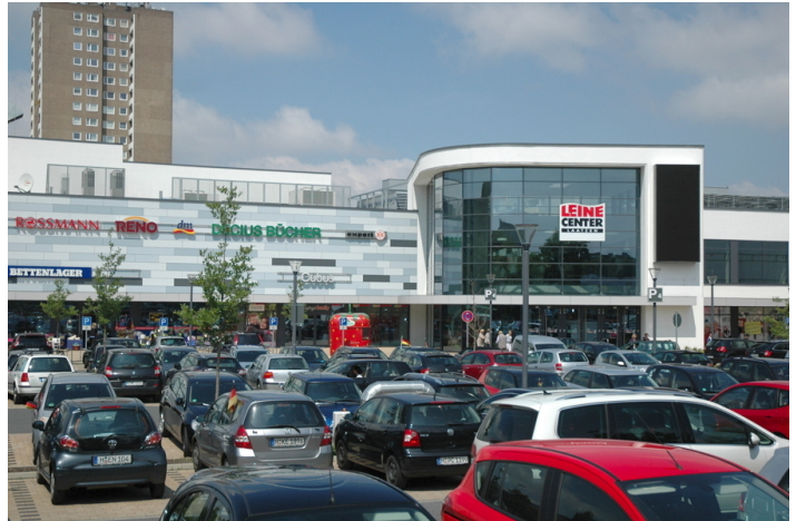
Das Leine-Center ist mit etwa 100 Geschäften eines der größten Einkaufsmeilen der Region Hannover
