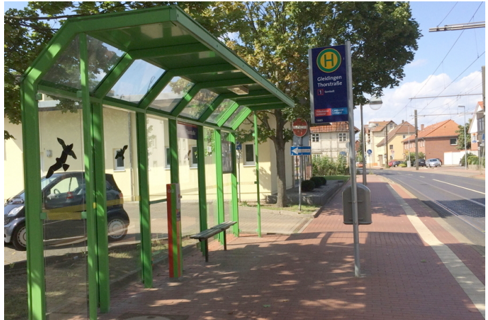
Die Haltestelle an der Thorstraße soll nach Forderung der SPD in einen Hochbahnsteig umgebaut werden.
