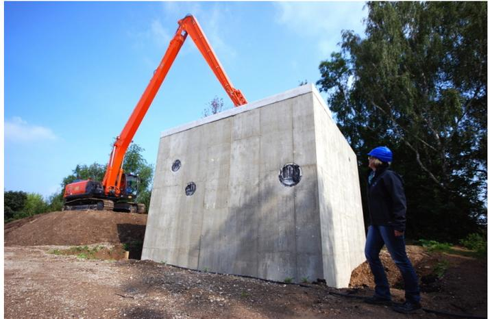
**Noch ist das Gerüst der Pumpstation sichtbar: Anja Gnad beobachtet den Bagger bei der Arbeit. In den nächsten vier Tagen wird der Betonklotz langsam in den Erdboden sinken.**
