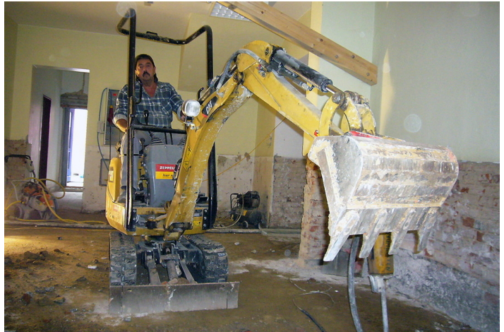
Horst Dieter Kirsch trägt im Bewegungsraum die marode Bodenplatte ab.
