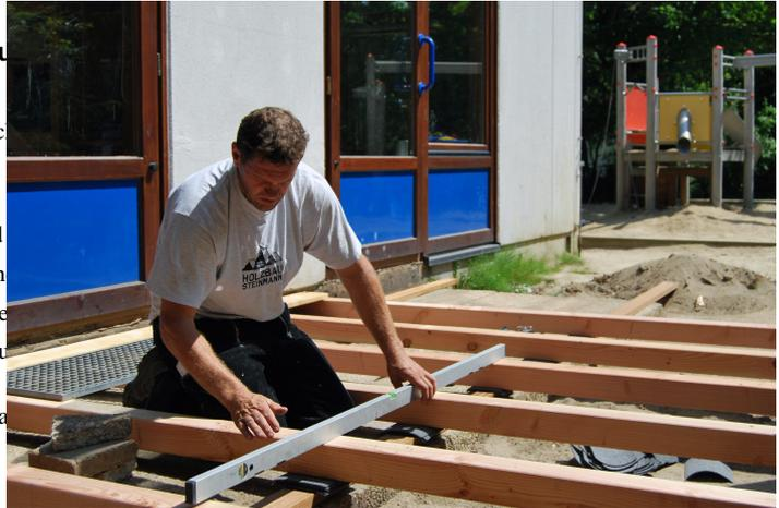
**Robert Maczuga von der Zimmerfirma Holzbau Steinmann baut die Unterkonstruktion für die neue Holzterrasse.**
