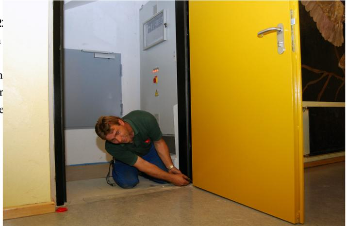
**Metallbauer Siegfried Osthues justiert die rauchdichte Brandschutztür zu einem Technikraum nach dem Einbau.**
