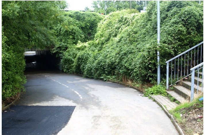
Der Tunnel am Bahnhof Rethen soll barrierefrei werden.
