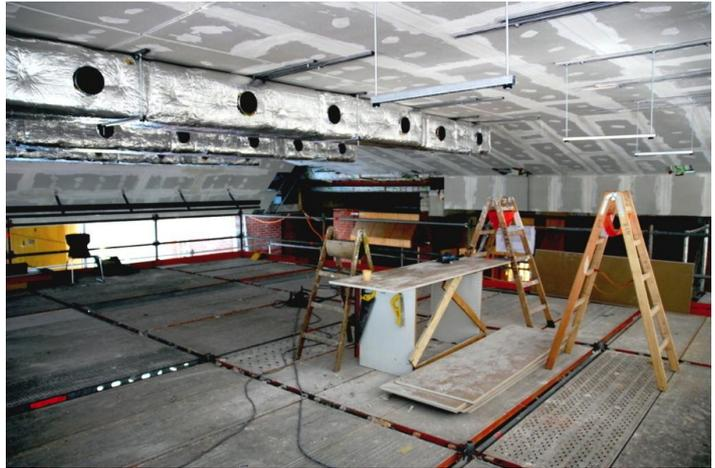
**Die Brandschutzdecke mit den Lüftungskanälen wird anschließend mit einer Akustikdecke verkleidet.**
