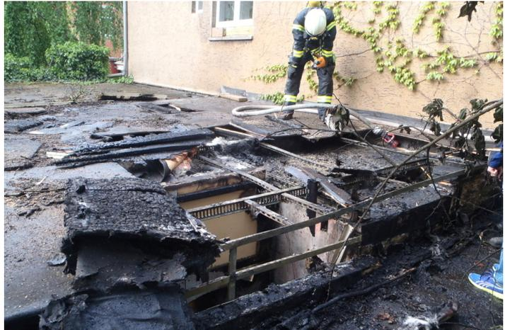
**Die Decke des Anbaus ist nach dem Feuer komplett zerstört, die Feuerwehr Gleidingen übernimmt die Brandwache.**
