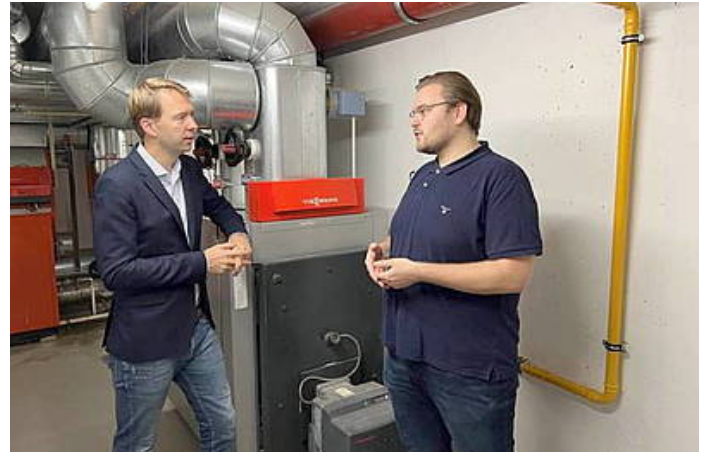
Jan Dingeldey (links) und Maik Brinkmann inspizieren eine Heizungsanlage. /
