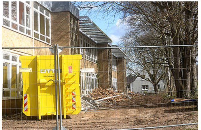
Die Demontage hat begonnen: Die Schule Auf der Kassebeerenworth wird abgerissen. / R. Kroll
